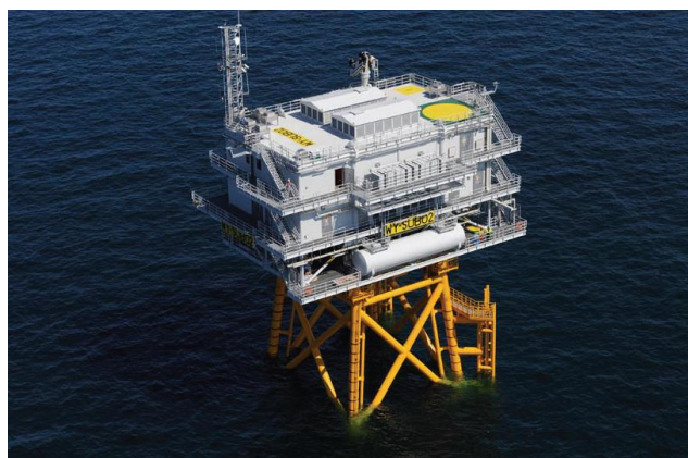
Figure 4 : Poste électrique en mer du parc éolien de Walney (DONG Energy)
